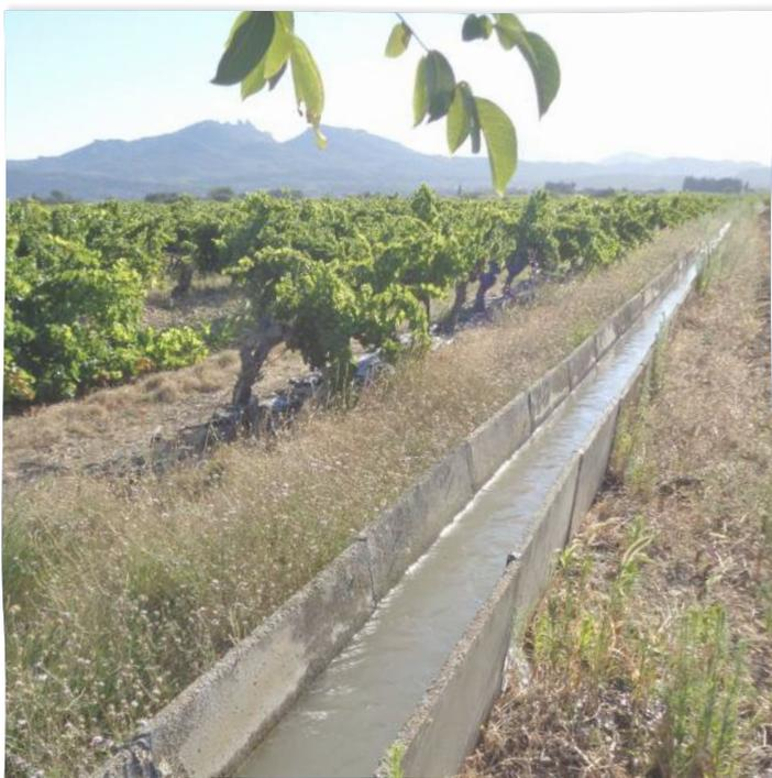
Filiole gravitaire sur le canal de Carpentras. © Canal de Carpentras
