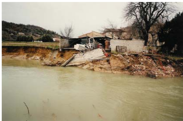
Local détruit par affouillement* en amont d'Apt en 1994.
