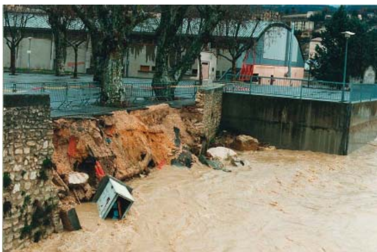
Le mur de protection effondré devant le Lycée lors de la crue du 7 janvier 1994.
