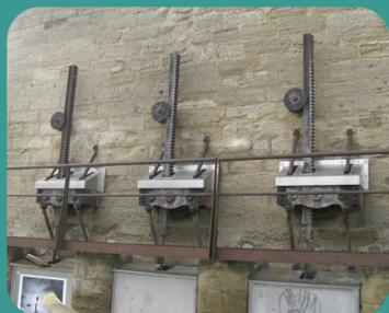
35 vannes permettent de réguler le débit d'entrée des canaux et de sortie des eaux usées. À partir de 4 m d'eau, on commence à fermer les vannes, afin d'empêcher le centre d'être envahi par les eaux de la crue. L'évacuation de l'eau est assurée par un système de pompage.
