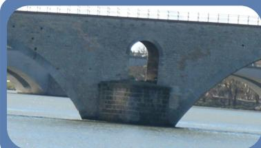
Vous pouvez observer que les piles du pont forment une pointe arrondie : c'est l'étrave. Cela permet de casser la force du courant et de laisser passer les embâcles de part et d'autre. Les petites ouvertures permettent de limiter la pression : en laissant passer l'eau, le pont offre moins de résistance. Malgré ces protections, le pont n'a pas résisté.
