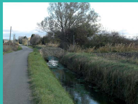
Pont sur la Mayre des Paluds
