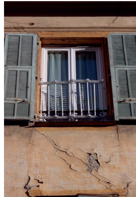
Lézardes sur bâti - Crédit Ville de Nice
