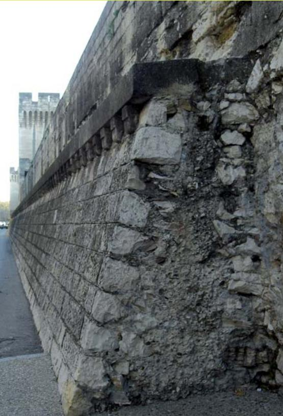
Après la grande inondation de 1856, des travaux de rénovation sont entrepris par Viollet-Le-Duc. Un contre-mur est alors construit le long des remparts pour les renforcer. Le risque d'inondation n'ayant pas la même importance partout, la hauteur du contre-mur est variable.
