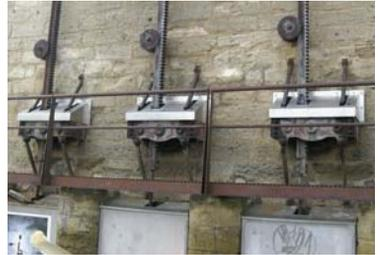
*35 vannes permettent de réguler le débit d'entrée des canaux et de sortie des eaux usées.*
